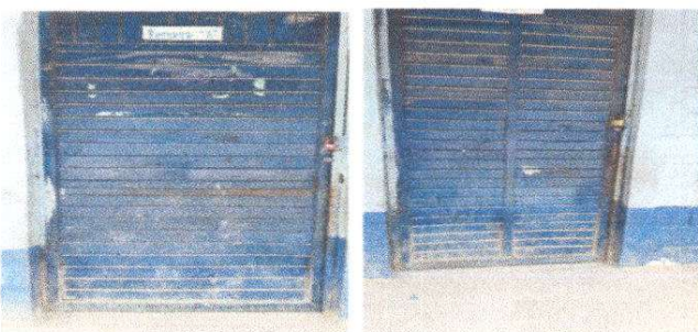
Foto 5: Sustitución de puertas
