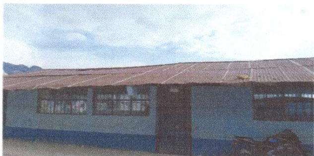
Foto1: Sustitución de lámina por lámina troquelada alucin calibre 26
