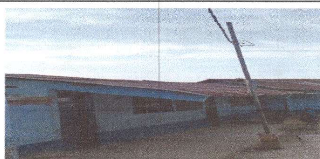
Foto 6: Pintura exteriores e interiores
