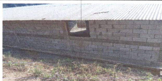
Foto 4: Repello y Cernido en muro
